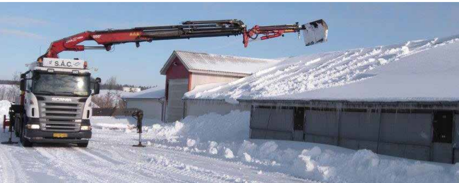
Sne fjernes fra taget af vognmandsfirma. På denne måde er der ingen risiko for, at personer falder ned.
