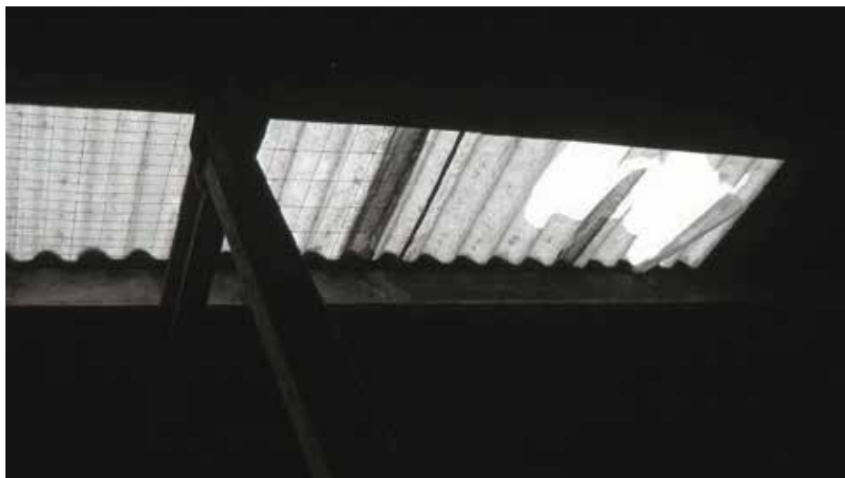
Her faldt en landmand gennem taget. Det kunne være forhindret ved at dække lyspladerne over.
