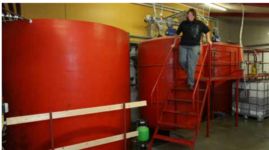
Platform ved vådfodertank etableret med rækværk og gelænder som alternativ til at stå på en stige.
